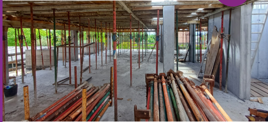
HCA - antigos Bombeiros (C.do Sal): execução de estrutura em betão armado
