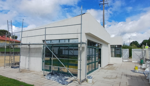
Piscinas Municipais: isolamento térmico em paredes exteriores; execução de acréscimo das platibandas da cobertura
