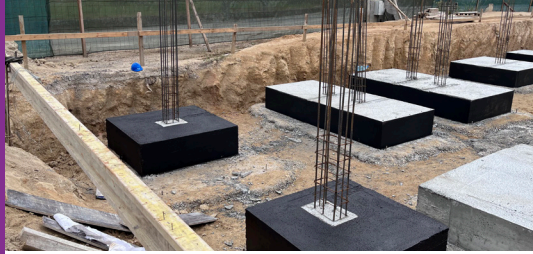
Habituação Colaborativa Vila Meã: execução da cofragem e impermeabilização das sapatas
