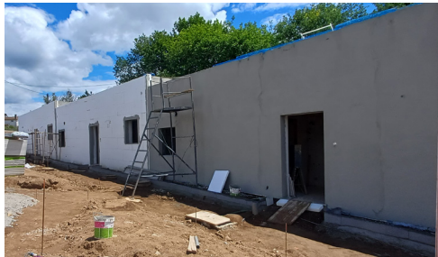
Habituação Colaborativa Cabanas de Viriato): isolamento térmico de paredes exteriores e execução de tetos falsos
