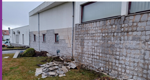
Biblioteca Municipal: demolição de revestimento das fachadas; execução de alvenarias no acéscimo das platibandas
