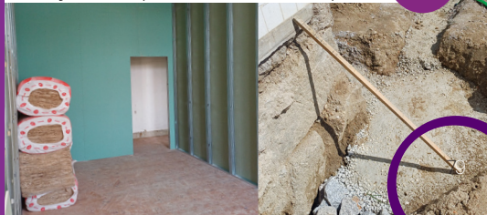
BNAUT de Vila Meã - execução de fundações e de paredes divisórias em pladur
