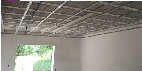
Habituação Colaborativa Cabanas de Viriato): isolamento térmico de paredes exteriores e execução de tetos falsos
