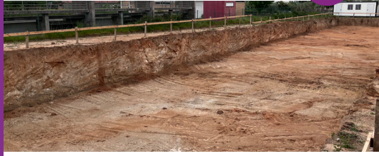
Habituação Colaborativa Oliveira do Conde: escavação para fundações
