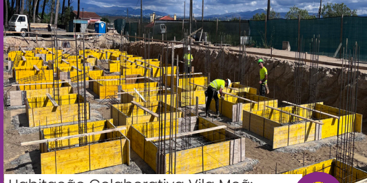
Habituação Colaborativa Vila Meã: execução da cofragem e impermeabilização das sapatas
