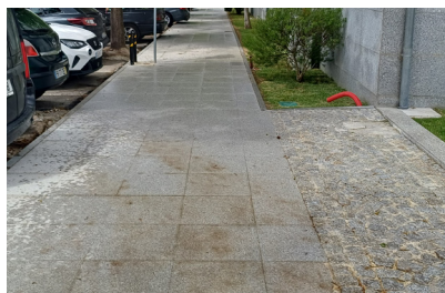
Acessibilidades 360º: execução de lajetas de betão; de pavimento podotátil e plantação de árvores
