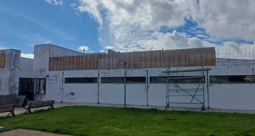
Piscinas Municipais: isolamento térmico em paredes exteriores; execução de acréscimo das platibandas da cobertura
