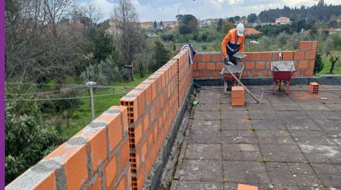
Biblioteca Municipal: demolição de revestimento das fachadas; execução de alvenarias no acéscimo das platibandas
