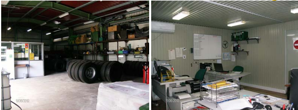
Exemplo da vista geral interior de um armazém e pormenor de um escritório de apoio à oficina
