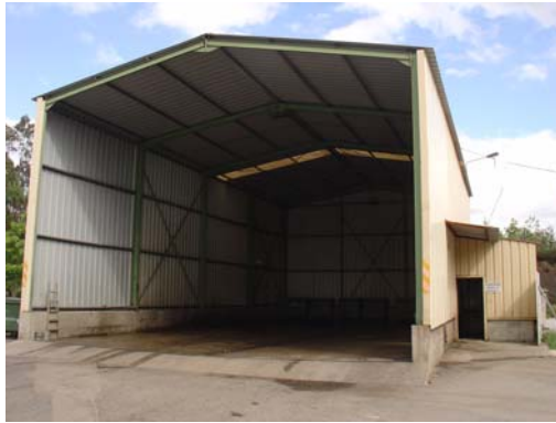
Exemplo de uma zona de lavagem de viaturas
