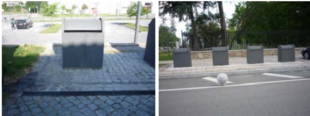
Contentores enterrados existentes em Tondela.
