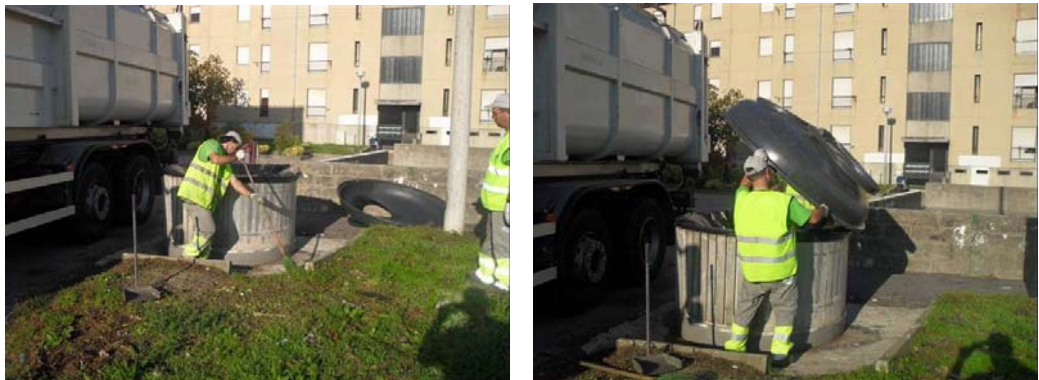
Limpeza da envolvente do molok e colocação da tampa.
