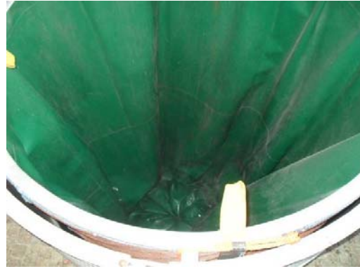
Colocação do saco de elevação no poço do molok.
