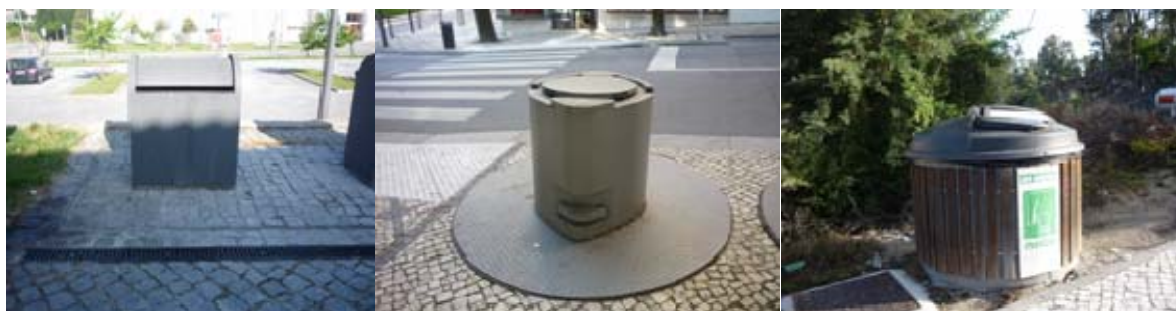
Contentores semi-enterrados e enterrados na região da AMRPB
