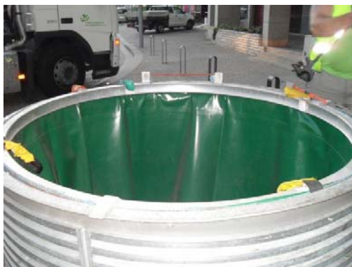
Colocação do saco de elevação no poço do molok.
