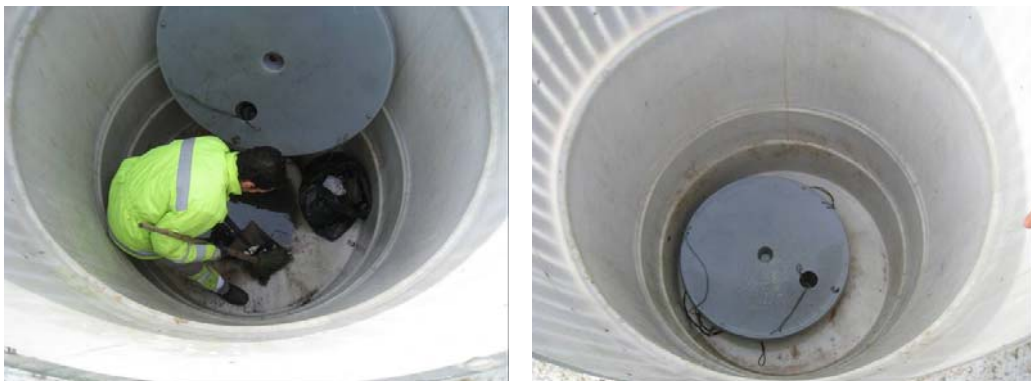
Cantoneiro a retirar os resíduos do interior do equipamento
