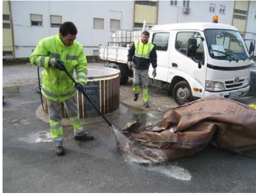
Lavagem do saco de elevação do molok.
