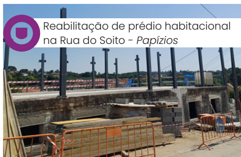
Reabilitação de prédio habitacional na Rua do Soito - Papízios
