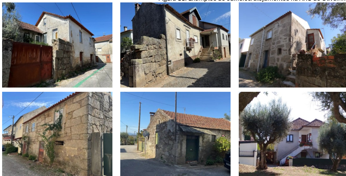
Figura 11. Exemplos de edifícios/alojamentos na ARU de Oliveirinha
