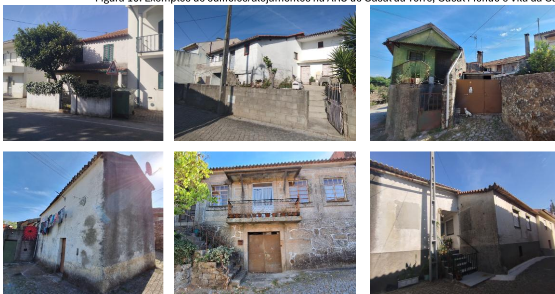
Figura 10. Exemplos de edifícios/alojamentos na ARU de Casal da Torre, Casal Mendo e Vila da Cal
