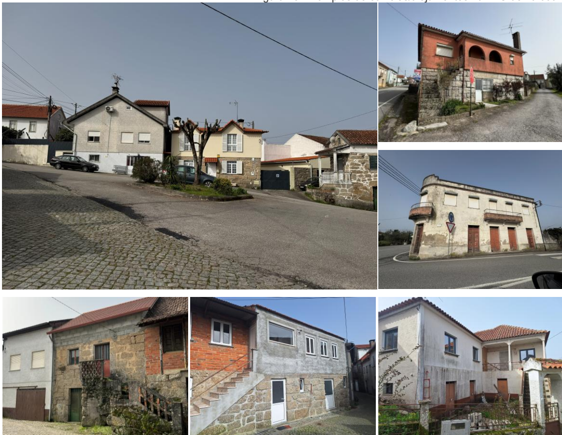
Figura 10. Exemplos de edifícios/alojamentos na ARU de Parada
