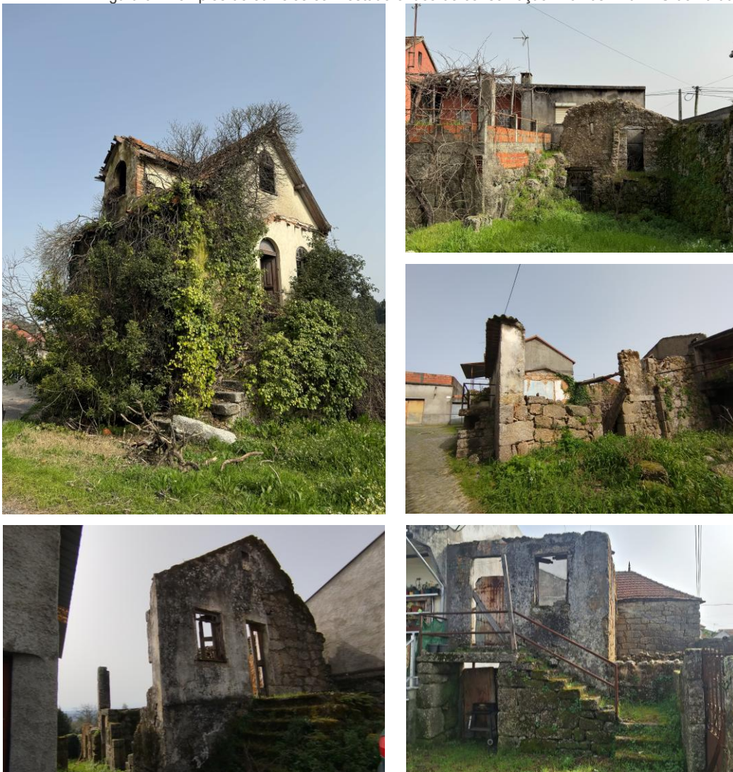
Figura 9. Exemplos de edifícios com estado crítico de conservação - ruínas - na ARU de Parada
