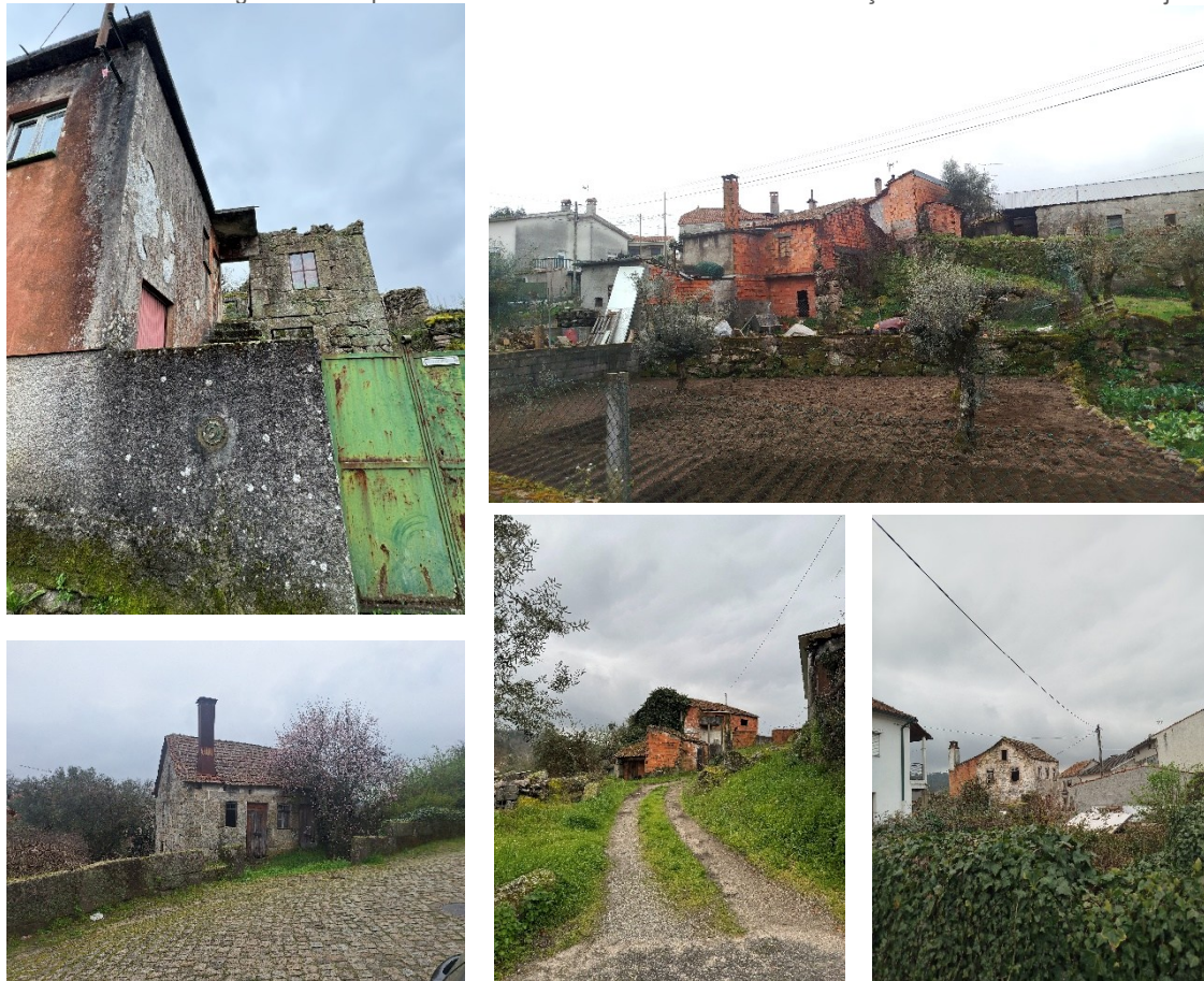
Figura 9. Exemplos de edifícios com estado crítico de conservação – ruínas - na ARU de Beijós
