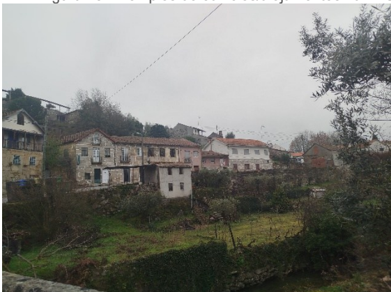
Figura 10. Exemplos de edifícios/alojamentos na ARU
