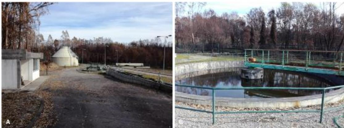
**Figura 31 – ETAR da Zona Sul de Tondela: A – Aspeto geral da ETAR; B – Tratamento Biológico**
