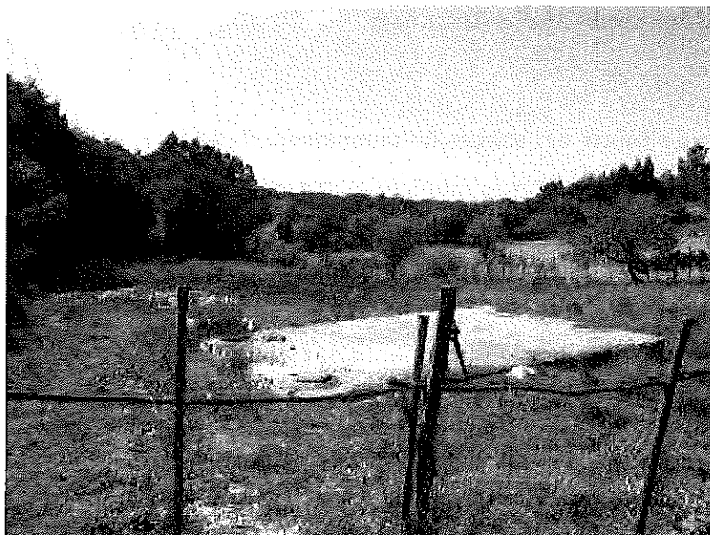
Figura 19 – Fossa séptica de Espariz I
