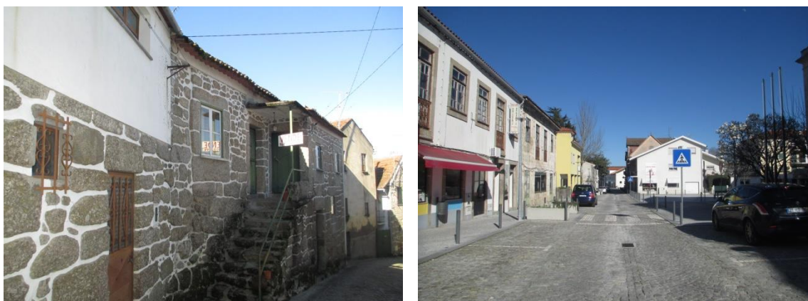
Figura 22: Volumetria e tipologia dos edifícios do centro histórico na ARU de Carregal do Sal
