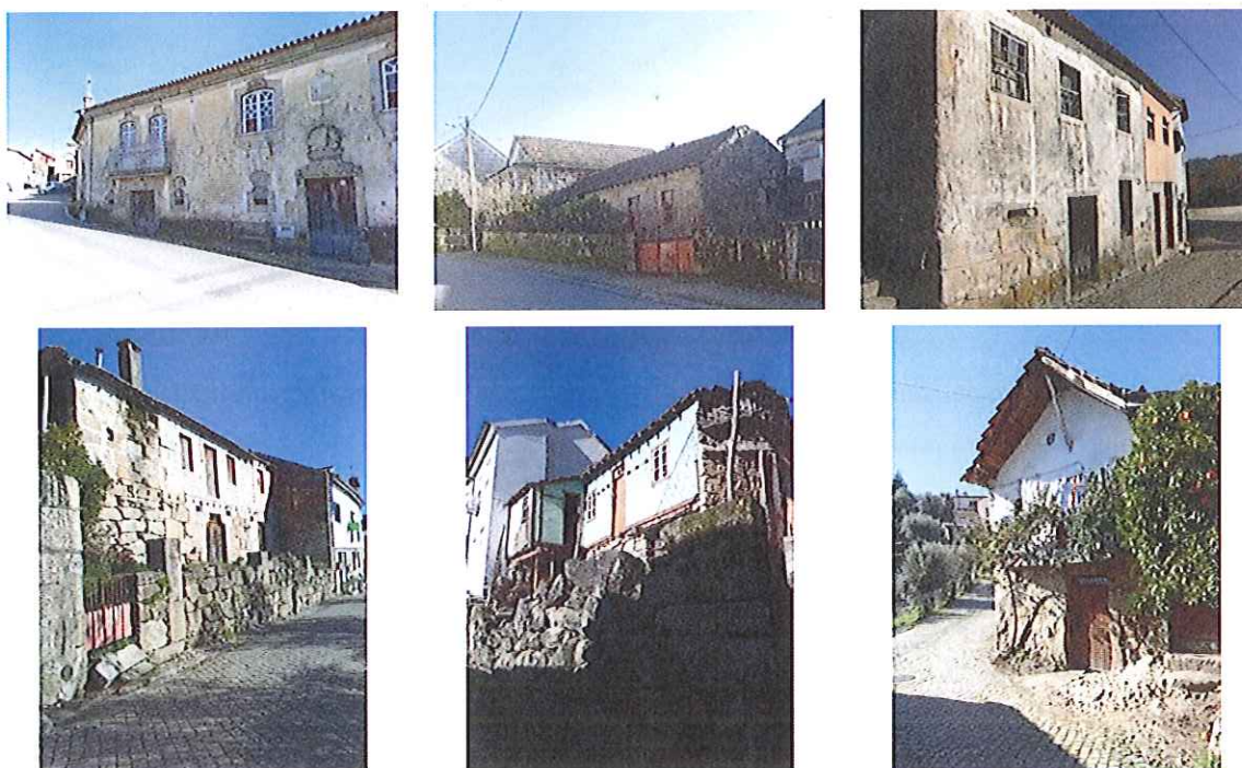
Figura 13. Exemplos do estado de conservação de edifícios na ARU de Beijós
