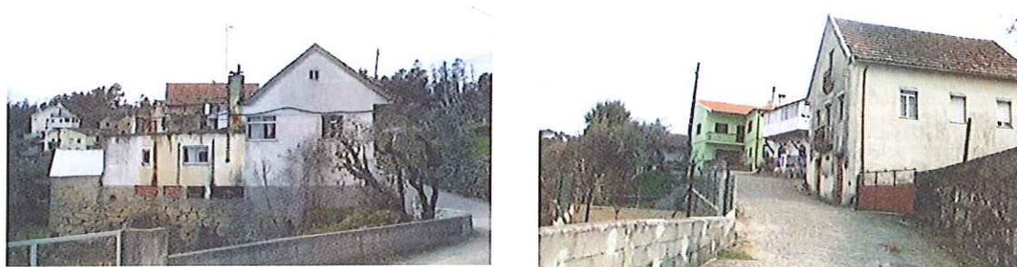
Figura 13. Exemplos do estado de conservação de edifícios na ARU de Papízios
